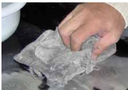
SCHŁADZANIE PODGRZANEGO MIEJSCA SZMATĄ MOCZONĄ W WODZIE
