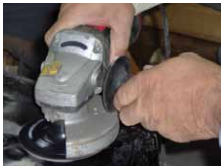
SZLIFOWANIE POWIERZCHNI BLACHY PRZED OBKURCZANIEM TERMICZNYM
