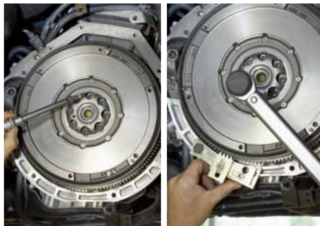
FOT. 4. MONTAŻ NOWEGO KOŁA DMF
