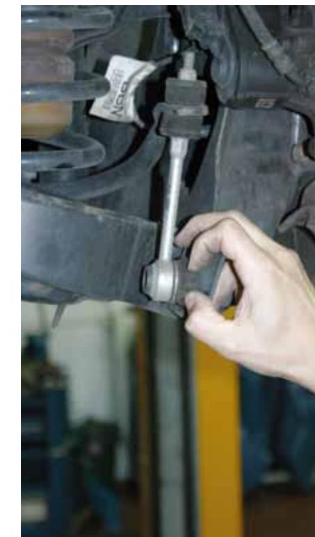
KONTROLA SZCZELNOŚCI OSŁONY PRZECIWPYŁOWEJ
