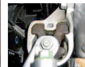
INSTALACJA DODATKOWEJ GUMOWEJ WKŁADKI W ELASTYCZNYM ZAWIESZENIU SILNIKA (SUBARU OUTBACK)
