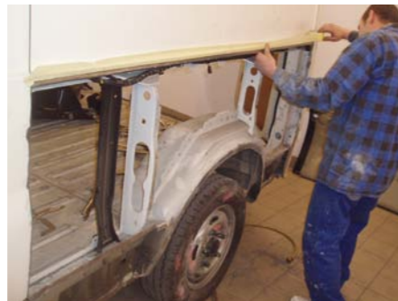
MASKOWANIE TAŚMĄ MALARSKĄ ŁĄCZONYCH KRAWĘDZI ELEMENTÓW CHRONI JE PRZED ZABRUDZENIEM PRZEZ WYCIEKI KLEJU ZE SPOINY
