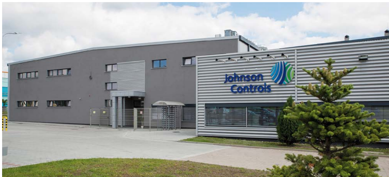
W TYM OBIEKCIE JOHNSON CONTROLS ZAINWESTUJE JESZCZE 80 MILIONÓW ZŁOTYCH!
