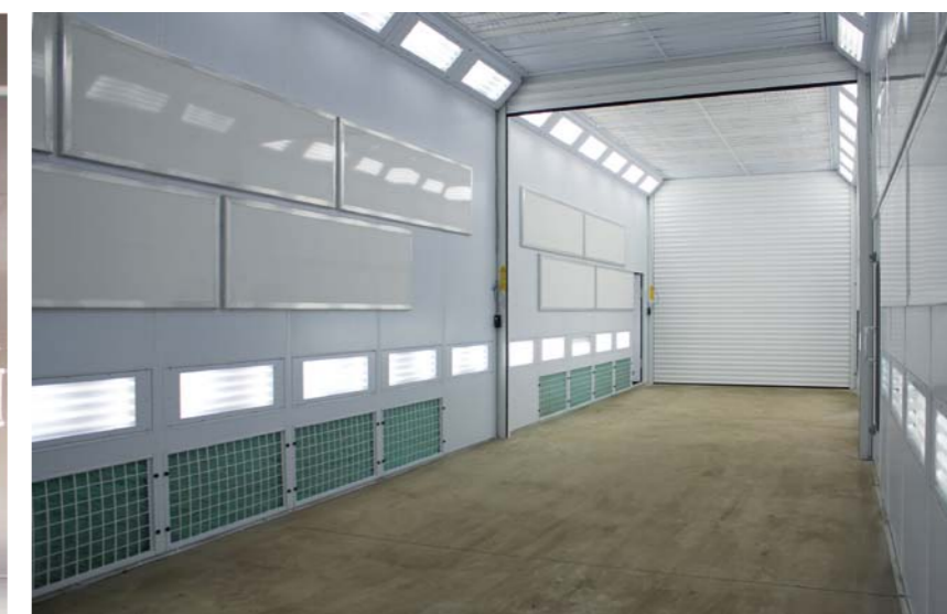
WNĘTRZE KABIN Z POZIOMO ZAMOCOWANYMI PANELAMI ENDOTERMICZNYMI
