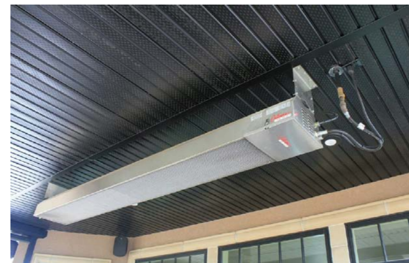
PANELOWE PROMIENNIKI PODCZERWIENI NAJČĘŚCIEJ SYTUOWANE W GÓRNYCH PARTIACH ŚCIAN MOŻNA RÓWNIEŻ ZAWIESZAĆ NA SUFITACH
