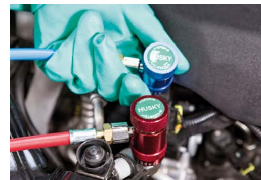
PODŁĄCZENIE STACJI SERWISOWEJ DO OBIEGU CHŁODNICZEGO
