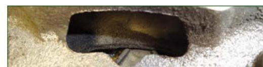
WIDOK PLYTKI FCP BEZ USZKODZEŃ PO DUŻYM PRZEBIEGU
